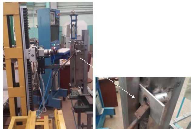
Рис. 3. Лабораторний стенд (а) для експериментальних досліджень з лазерного зварювання кільцевих зварних з'єднань (б) з різномірних сталей у вертикальному просторовому положенні
